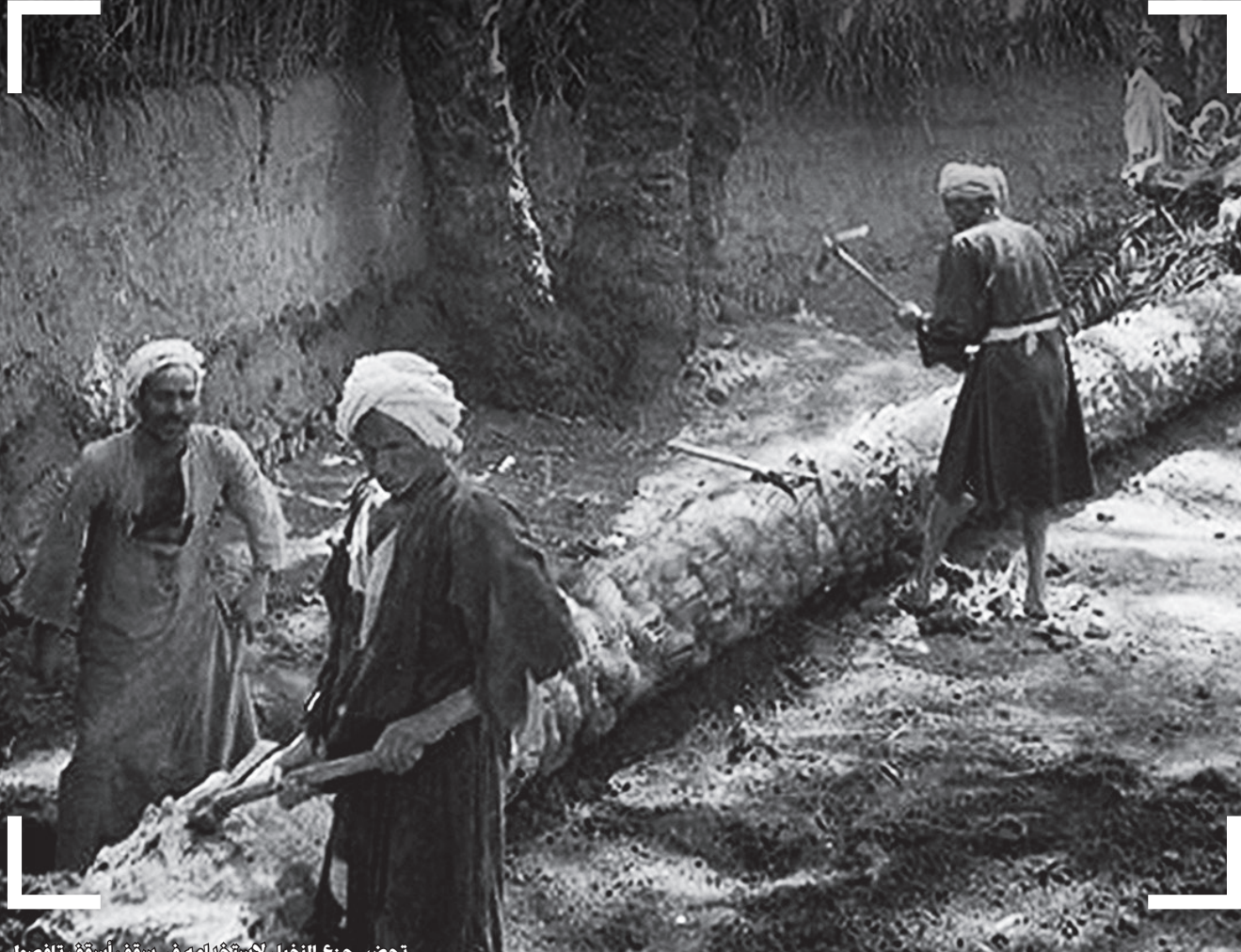
تحضير جنج النخيل لاستخدامه في سقف أسقف تافصول
